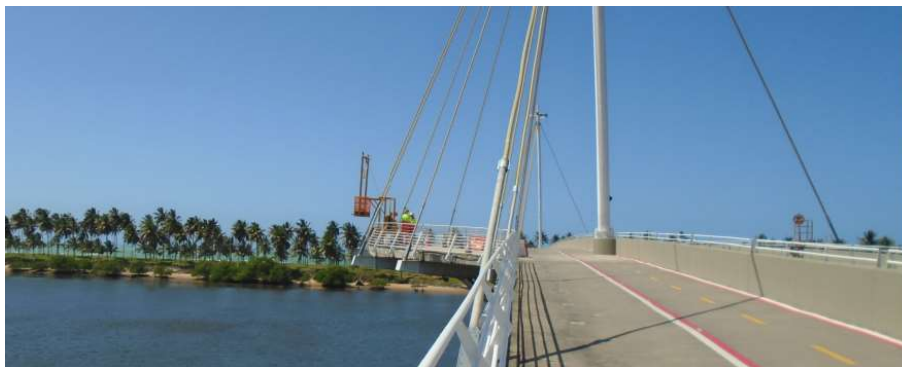
Figura 11. Etapa final da recuperação das estruturas metálicas das praças estaiadas da ponte.
