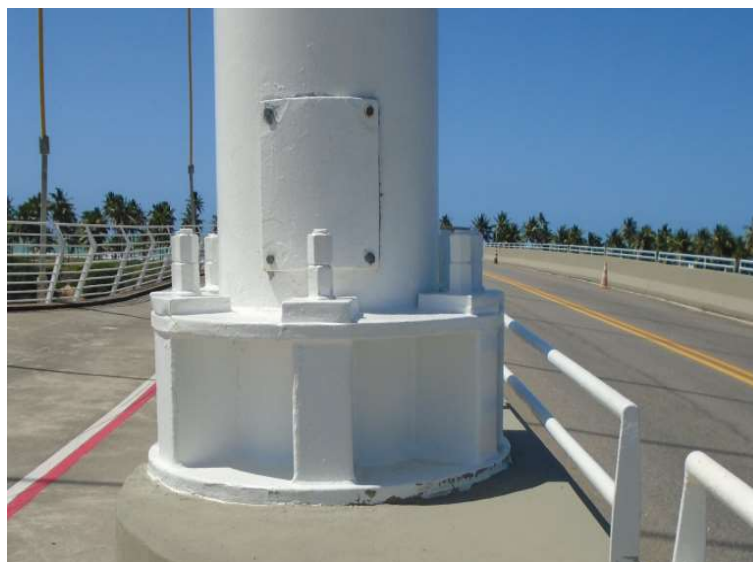
Figura 10. Mastro totalmente recuperado, mostrando também a recuperação dos parafusos da base e a recuperação dos guarda-corpos metálicos.
